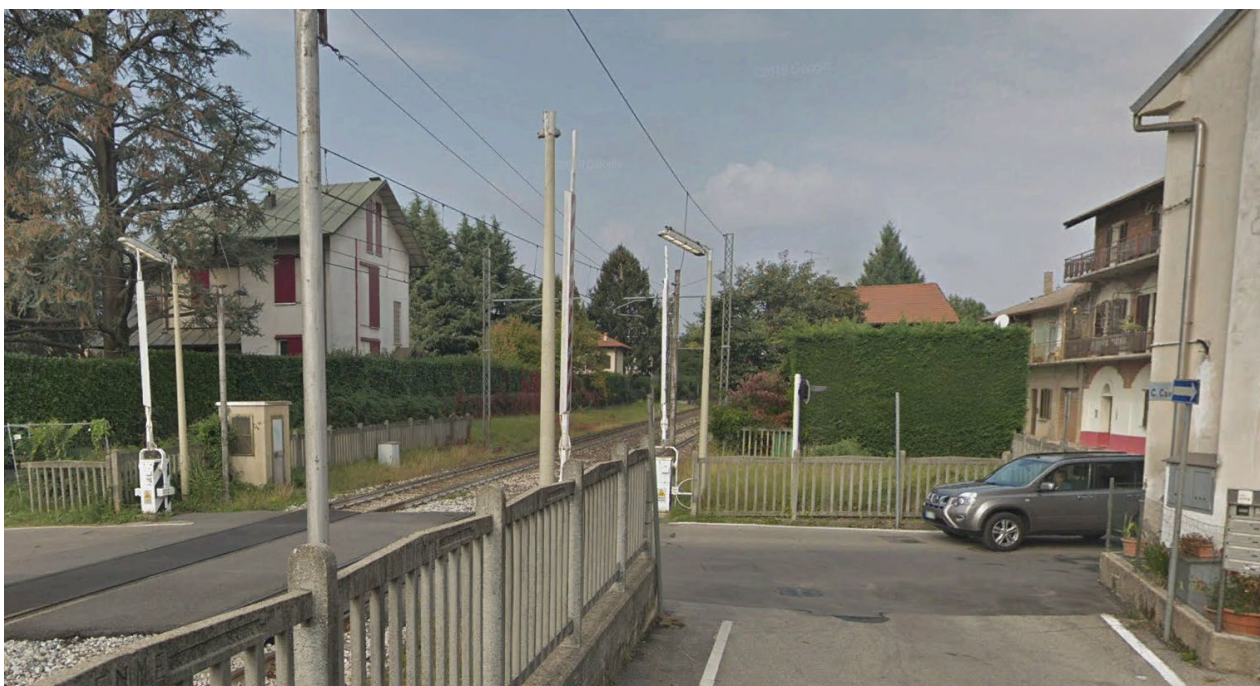
Figura 37 - PL di Via Mazzini (vista da Via Cavour)
