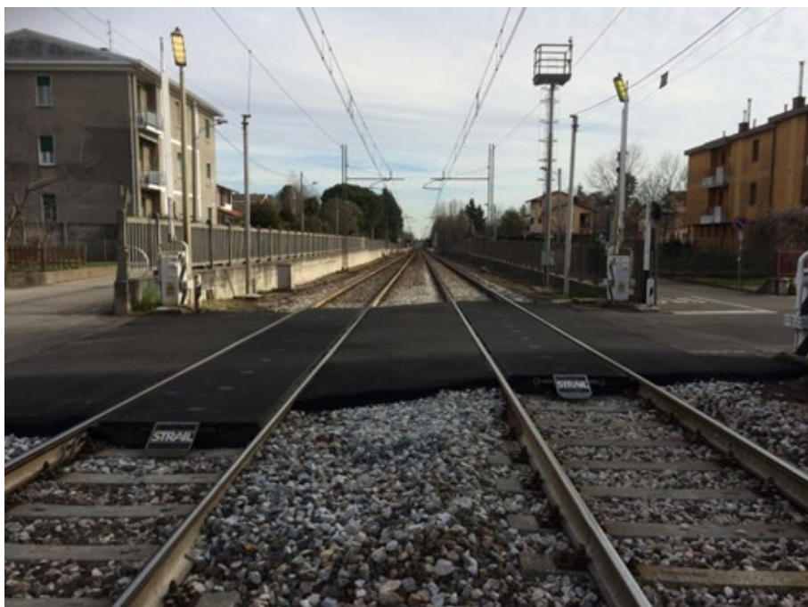
Figura 34 – PL di Via Mazzini (vista dir. Stazione Locate Varesino)
