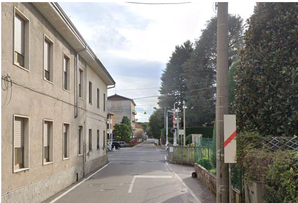
Figura 36 - PL di Via Mazzini (vista dir. Via Cavour)
